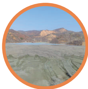
Presa de cola
